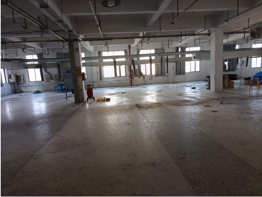
图 2-3 现场空置厂房照片
